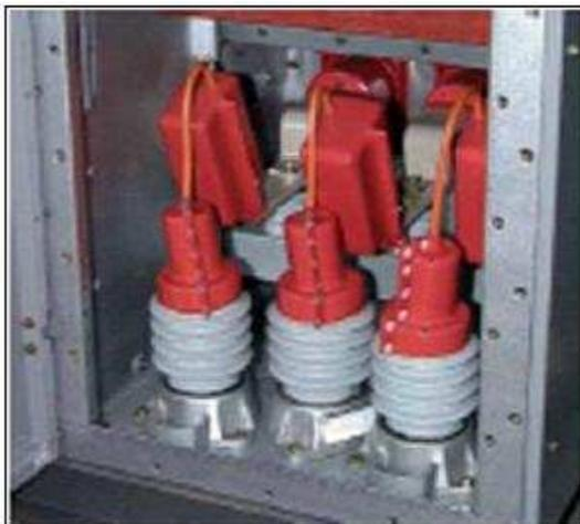
**Figura 46. Apartarrayos en equipo metal-clad.**
