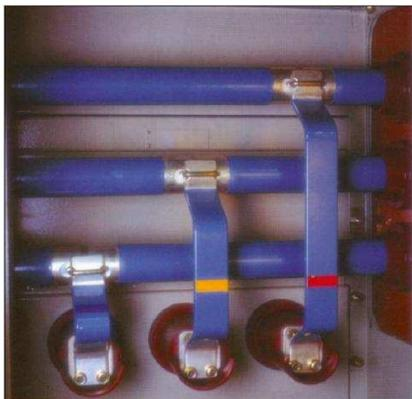
**Figura 39. Barras colectoras de sección tubular.**
