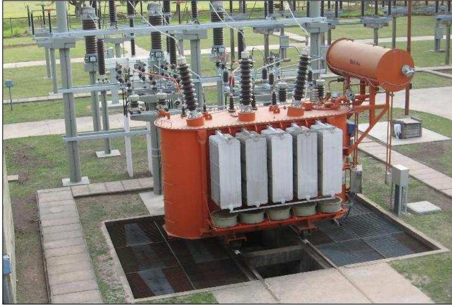
**Figura 4. Transformador de potencia<sup>3</sup> .**
