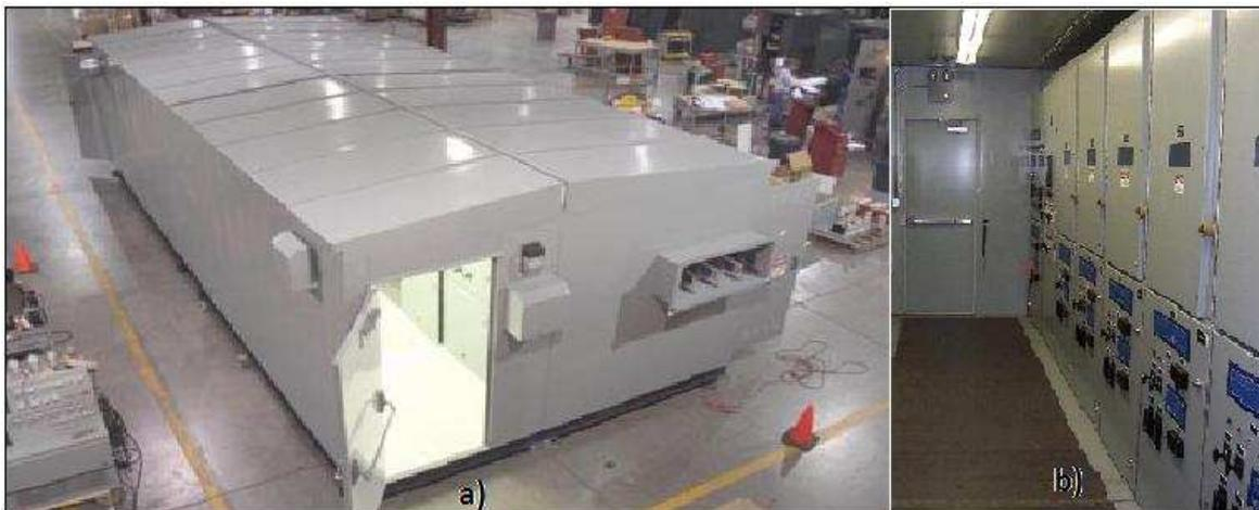
**Figura 30. a) Vista exterior celda metal-clad de tipo exterior con pasillo. b) Vista interior celda metal-clad de tipo exterior con pasillo.**
