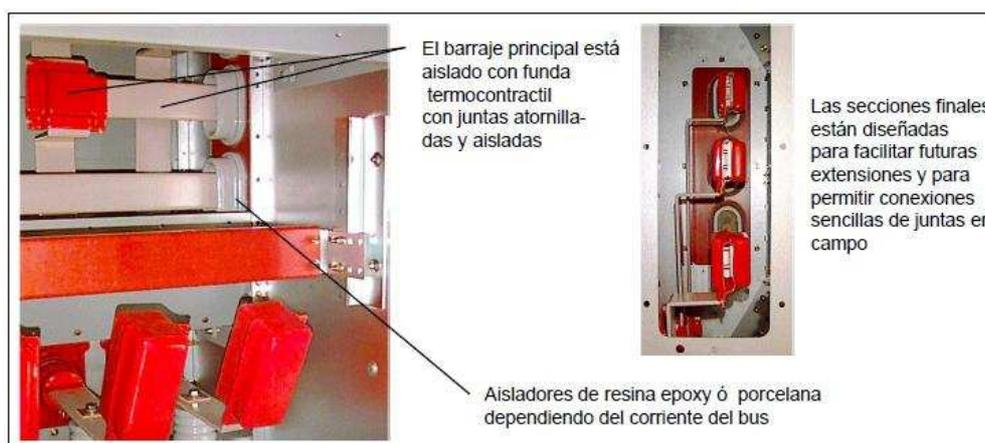
**Figura 38. Barra colectora de sección rectangular de celdas ABB.**
