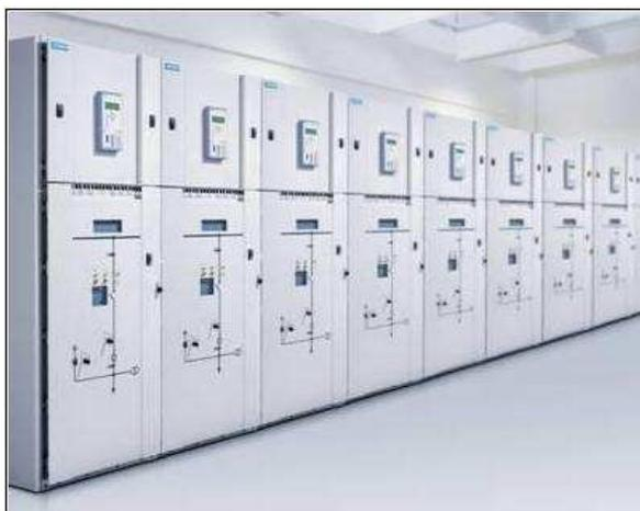
**Figura 28. Celdas metal-clad tipo interior.**
