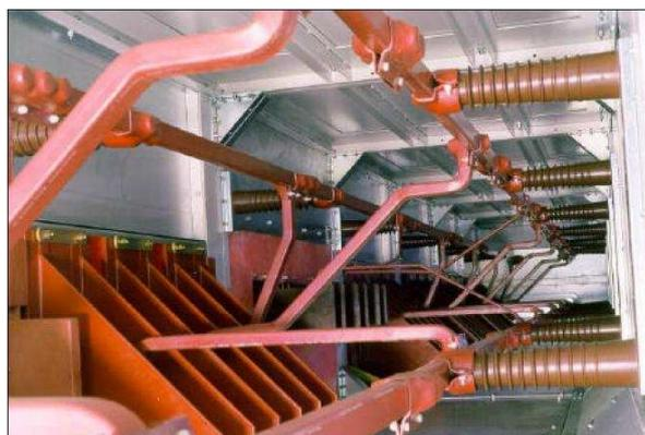
**Figura 37. Embarrado de equipo metal-clad.**
